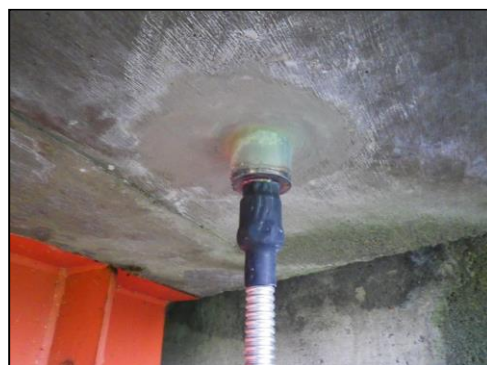
既設床版の補修工事で設置
