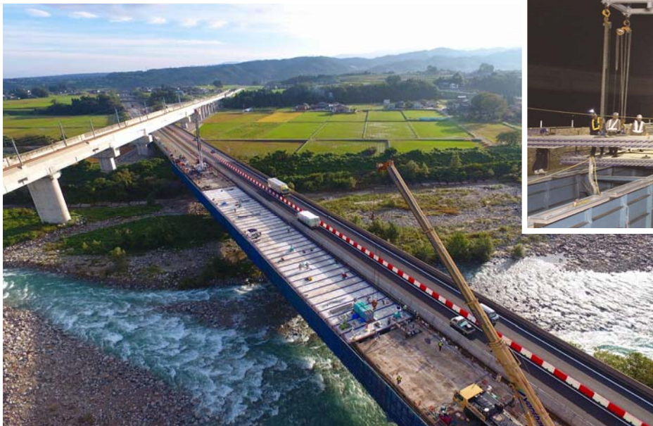
高速道路橋の床版取替え
