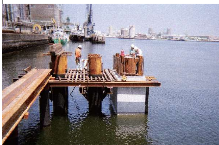
用途例: 栈橋補強工事(水中充填)
