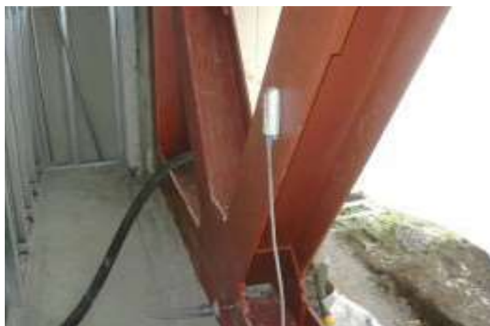
用途例: 建築耐震(ブレース工法)
