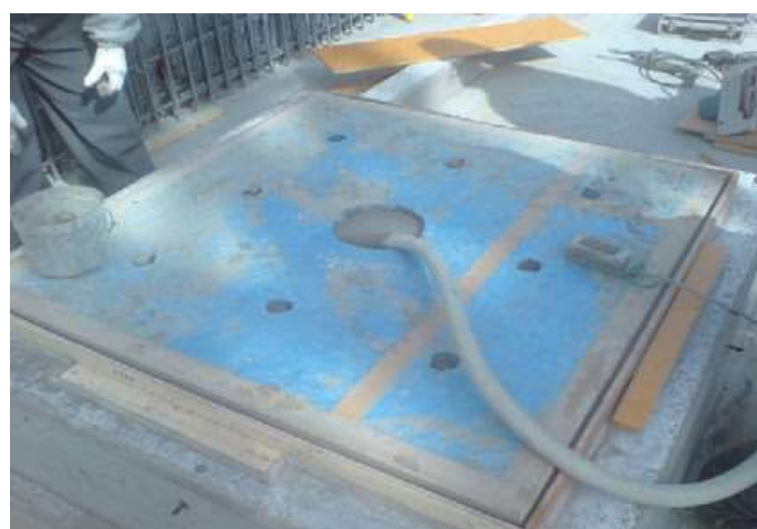
用途例: 免震グラウト
