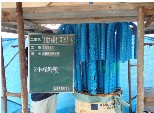
ニッカエポランNに『エポキシ樹脂塗装鉄筋』を浸漬
