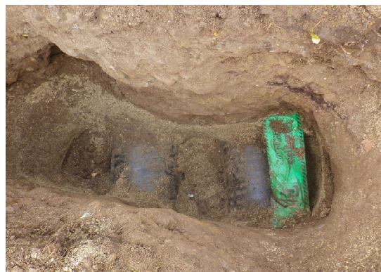
埋設管確認状況
