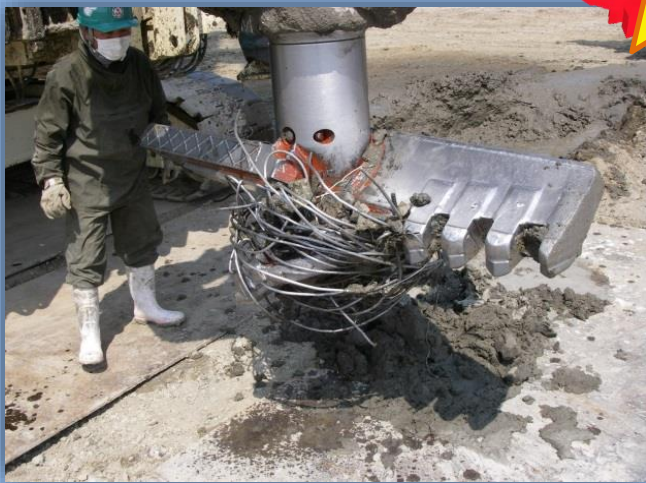
杭破碎同時施工
