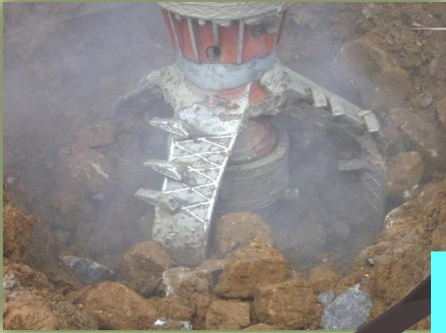
硬質地盤施工
