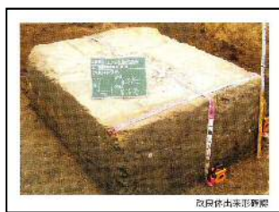
写真-2 改良体出来形
