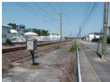
施工後5年6カ月経過 (平成29年6月撮影)
