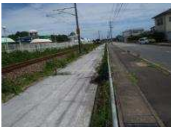
施工後1年8カ月経過 (平成25年8月撮影)
