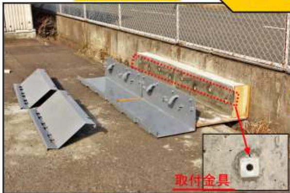
新しい鋼製排水溝の設置
