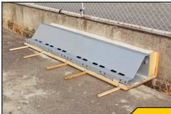
新しい鋼製排水溝の設置
