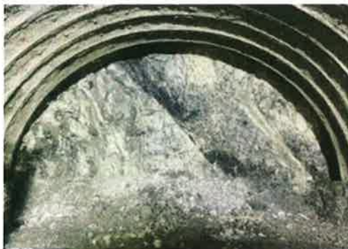
(a) 掘削直後の切羽
