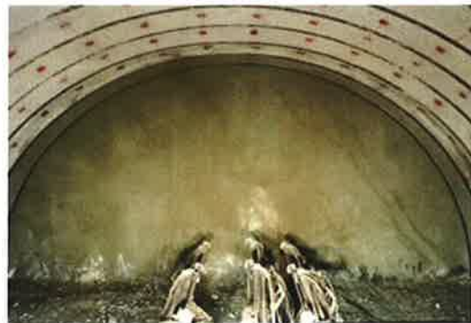
(b) 鏡吹付けコンクリート施工
