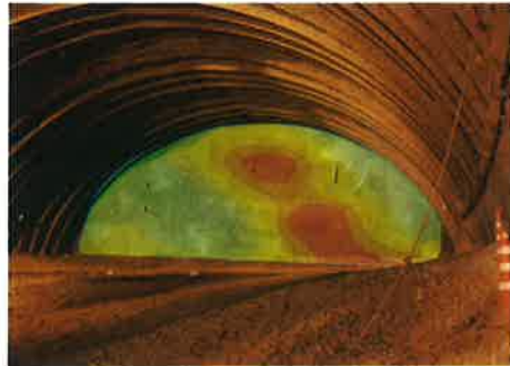
切羽の押出し
