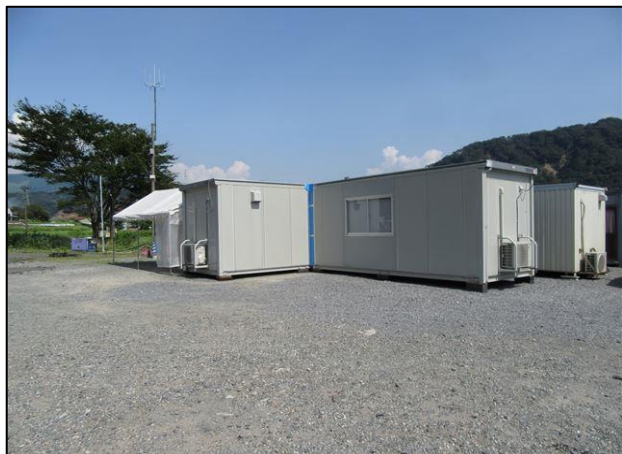
超遠隔操作室外観
