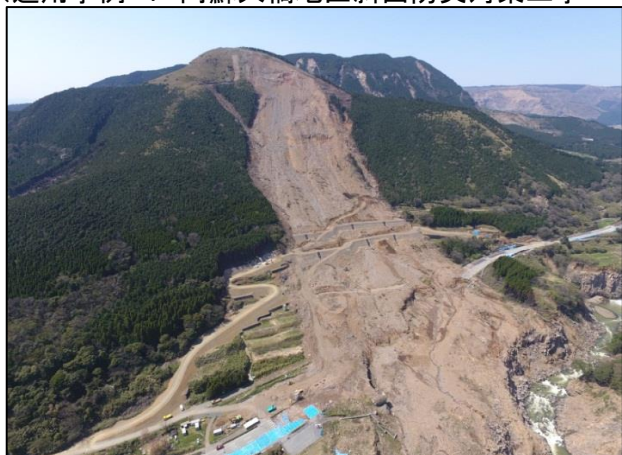
無人化施工エリア全景
