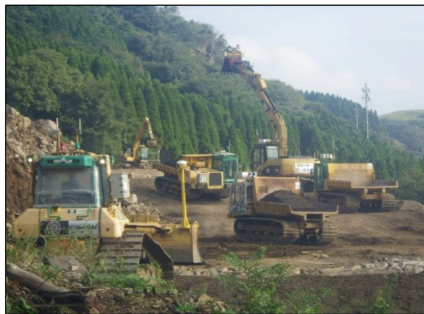
土留盛土工無人化施工状況
