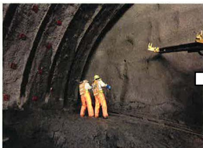
④-1 ロックボルトの人力作業
