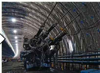
④-2 ロックボルトの機械化(3ブースフルオートジャンボ)
