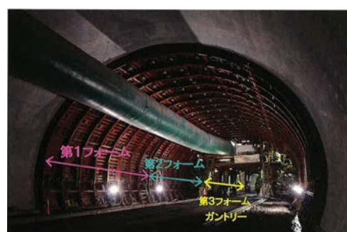
⑤-2 TrAF工法(国道45号唐丹第3トンネル)
