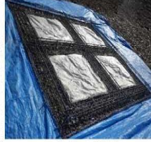
5. 枠内シート設置
