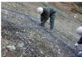
3. 鉄筋・組立枠設置
