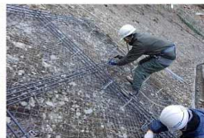
4. アンカー打設
