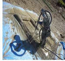
6. 枠モルタル吹付
