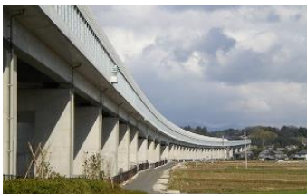
■橋やトンネル■ インフラ構造物の点検
