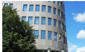
■ビル外壁■ はく離やタイル浮きの診断
