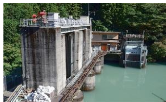
■ダムや水門・樋門■ 大規模構造物検査
