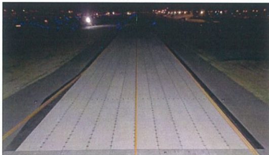
福岡空港誘導路完成写真
