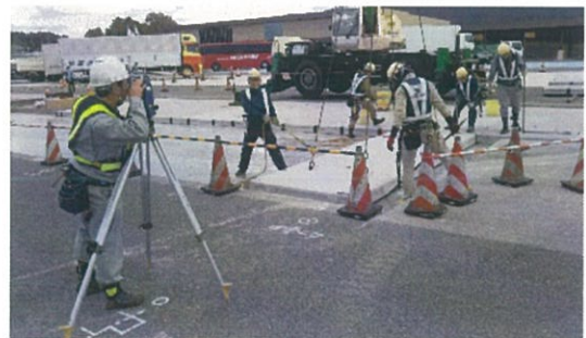
九州自動車道古賀SA施工状況
