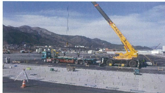
大船渡港施工状況
