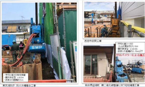
図-4 家屋近接工事
