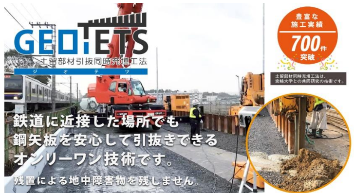
図-3 鉄道近接工事
