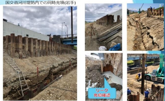
図-5 堤体内工事
