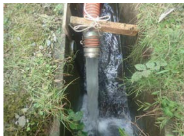
図5: 排出水確認 洗浄7回目
