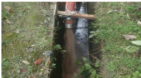
図4: 排出水確認 洗浄1回目
