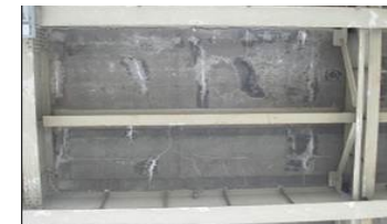
RC床版のひび割れ
