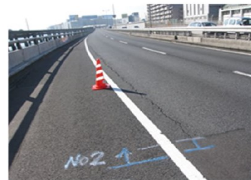
護岸埋立構造の路面ひび割れ
