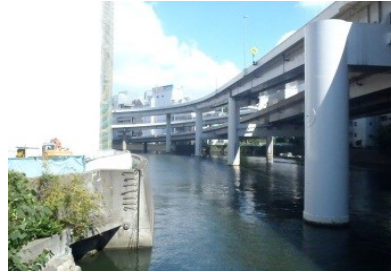
日本橋川内の鋼製橋脚(江戸橋JCT)
