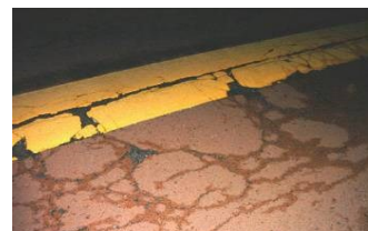
舗装のひび割れ
