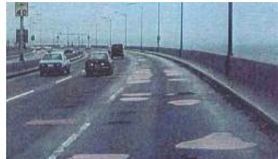
【有料橋の床版補修】
