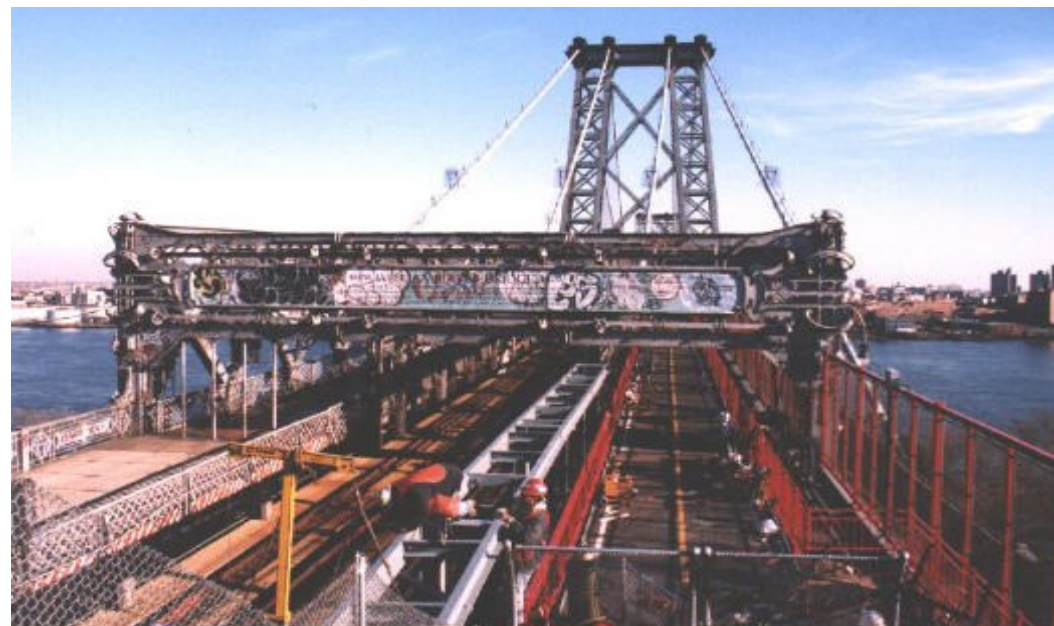
桁の取替え工事
