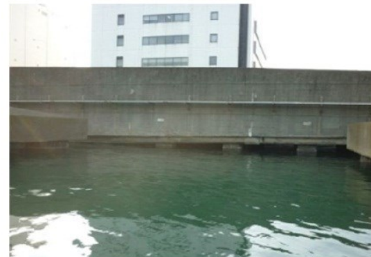
満潮時の栈橋構造 (海面近接部)
