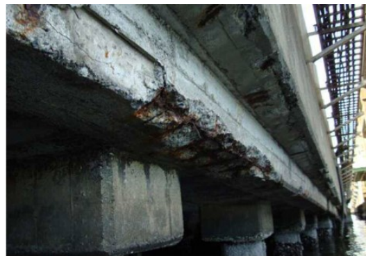
鉄筋腐食によるコンクリート剥落
