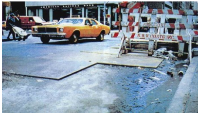
【損傷が進んだ舗装】
