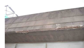
高欄水切り部の剥落
