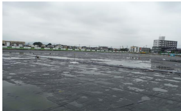
写真-3 施工状況(ポンプ運転中)
