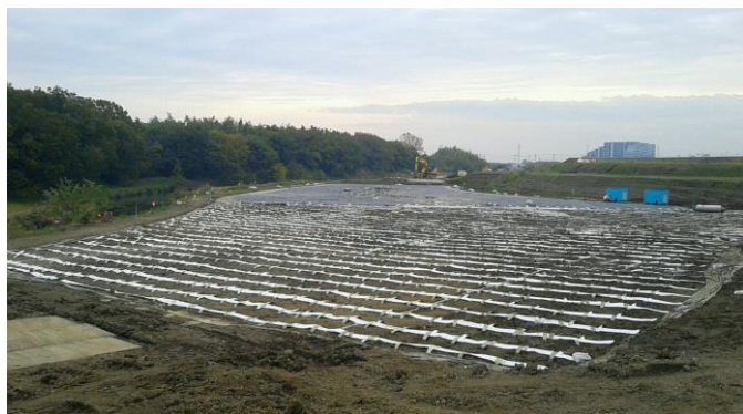
写真-2 施工状況(水平ドレーン・シート)
