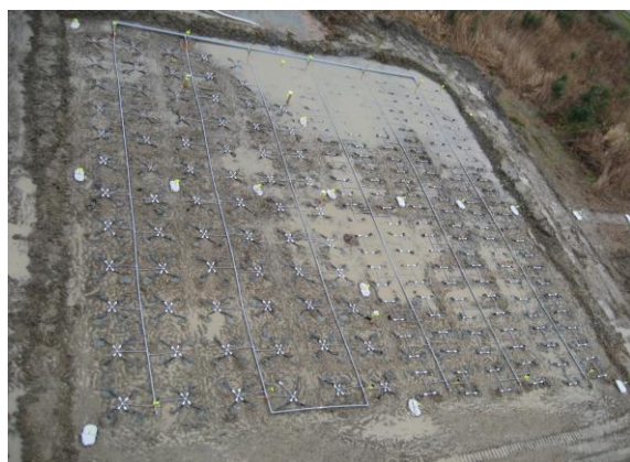
写真-3 施工例(全景)
