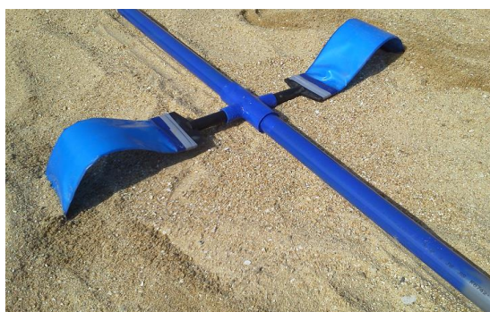
写真-1 ドレーンと集水管接続例
