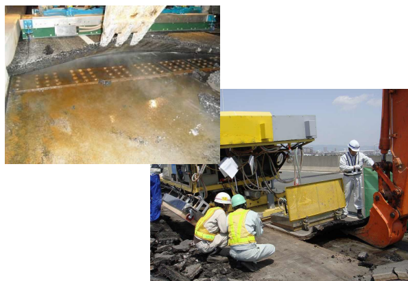
図4. 1号機による撤去状況
