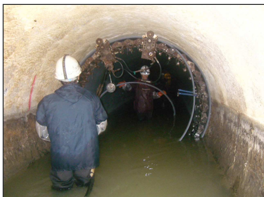
[円形渠(下水道管渠)の更生]
