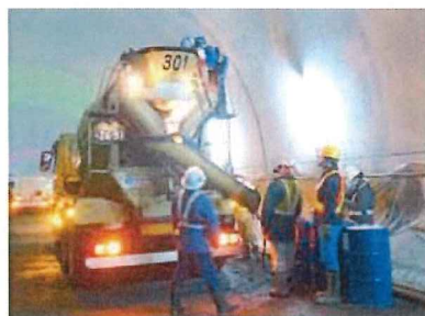
流動化剤の現場添加状況
