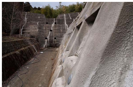
水路内に突起物をつくらず、護岸を補強
