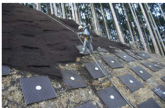
受圧板との併用で、法面を全面緑化
