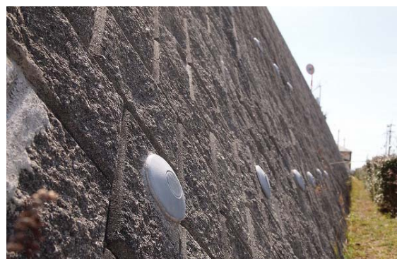
突起物をつくらず、擁壁を補強
