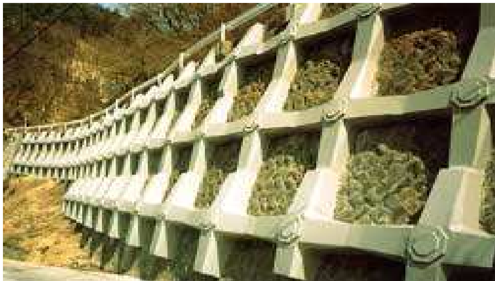
PCフレームアンカー工法
