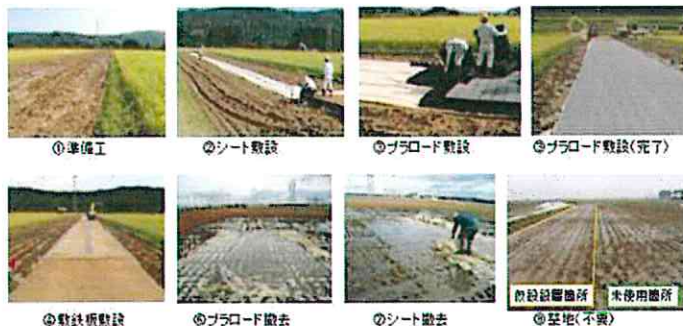
○プラロード作業手順
