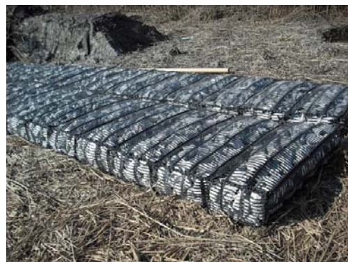
中詰材充填後
