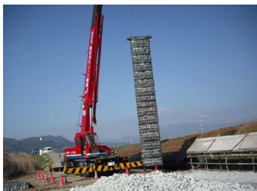
吊上げ状況 《片吊り》
