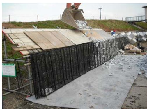
中詰材充填用架台、中詰材充填
