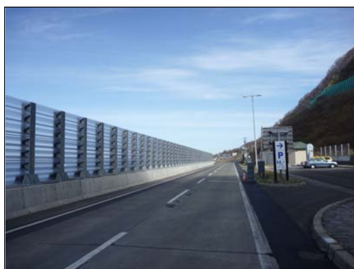
写真-2 防波フェンス(一般国道)の設計に適用され、設置された事例
