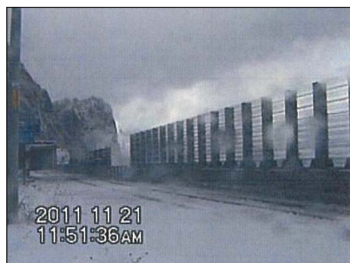
写真-3 道路への越波水進入の抑制例
