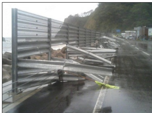
写真-1 越波による被災例
