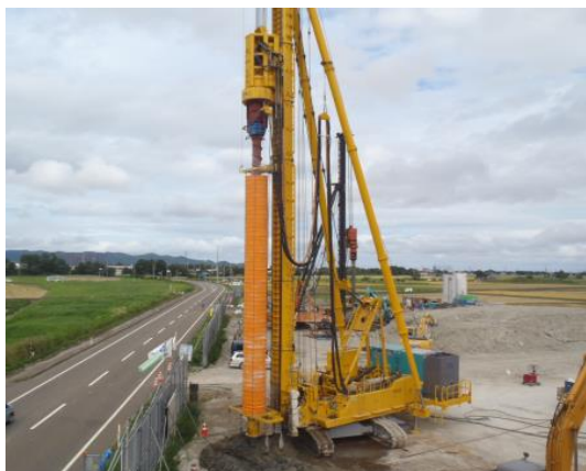
施工状況(KS-S・MIX)
