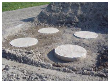
出来型杭径確認
