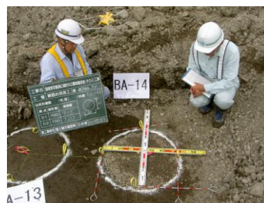
出来型杭径確認
