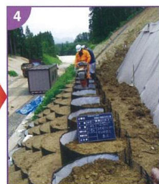
〔中詰材・裏込材転圧〕
