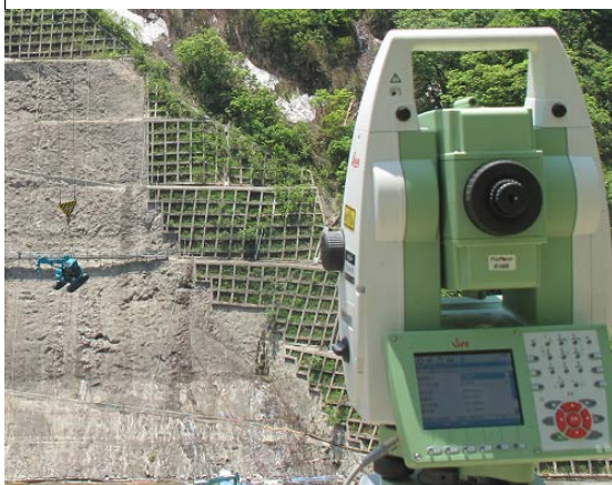
法面の計測の現場
