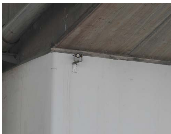
橋脚に設置したプリズム
