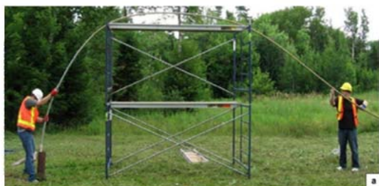
①ボーリング孔にガイド管+SAAを挿入
