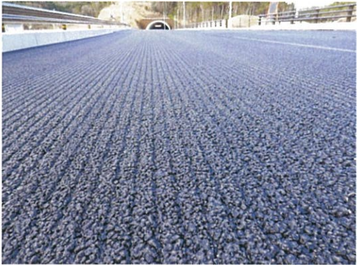
仕上がり路面の例
