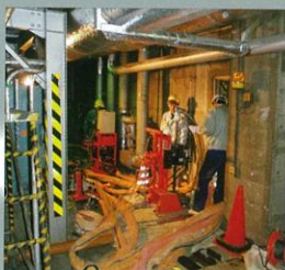
超小型施工機での施工状況
