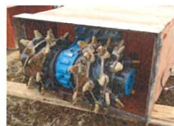
掘削装置 前面 (函体にセットした状態)
