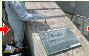
黒錆促進剤であるJM-S200を鉄部露出部に薄く塗布する。キレート効果により素地とエポガードの密着性も高める。
