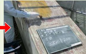
エポガード200で強靱な被膜を作成し、水・空気・酸・アルカリ等の外的要素から守り、塗膜下で黒錆化への熟成と安定化を図る。
