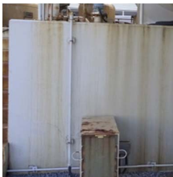
ASRの損傷範囲の例(調査業務の例2)
