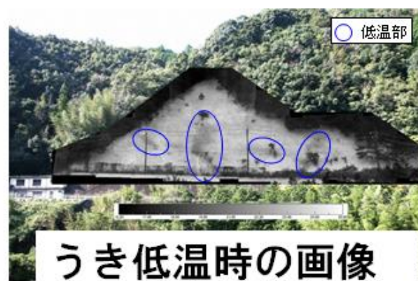
図－3 浮き撮影例(法面)
