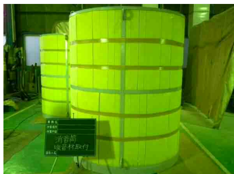
消音筒吸音材交換
