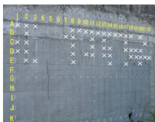
実構造物の打音検査
