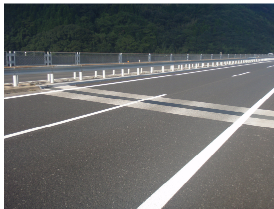
高速自動車道
