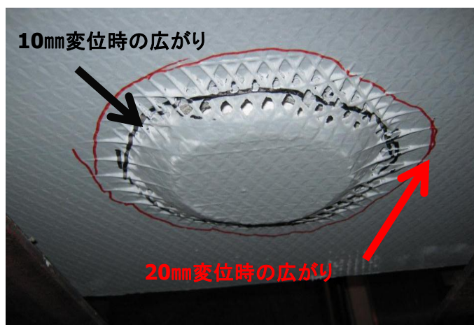
押抜き試験中
