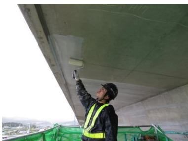
①道路橋床版下面 ローラーにて施工
