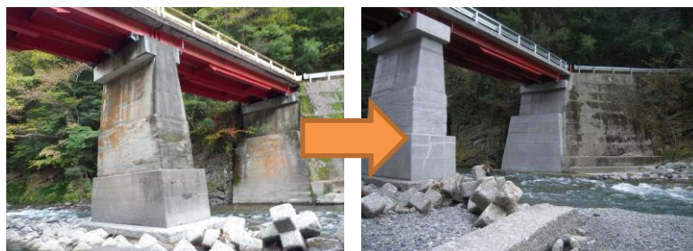
④橋脚の施工前と施工後の様子 (グレー色タイプで塗布)
