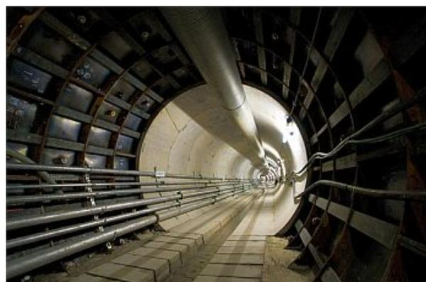
網製セグメント充填(新設シールドトンネル)
