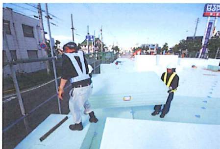
【ウォールブロック工法の標準図面と施工中の写真】
