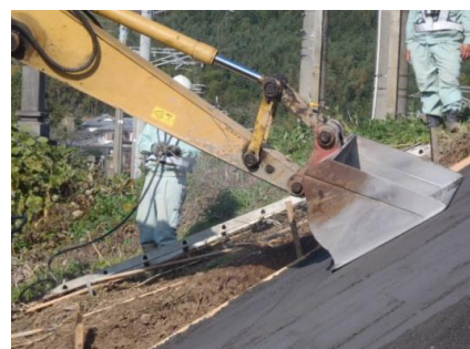
土羽打ち状況
