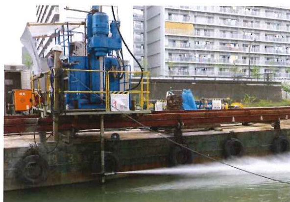
先端モニター噴射状況
