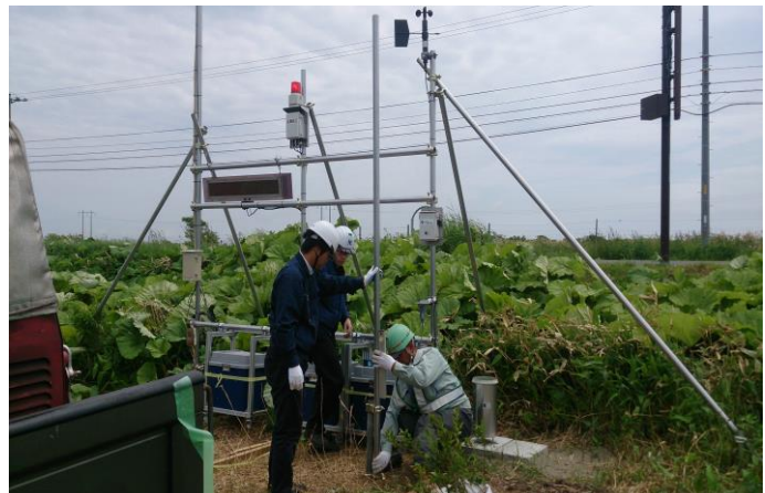
北海道根室市取付現場写真②
