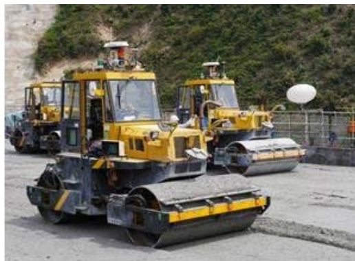
五ヶ山ダムでの稼働状況①
