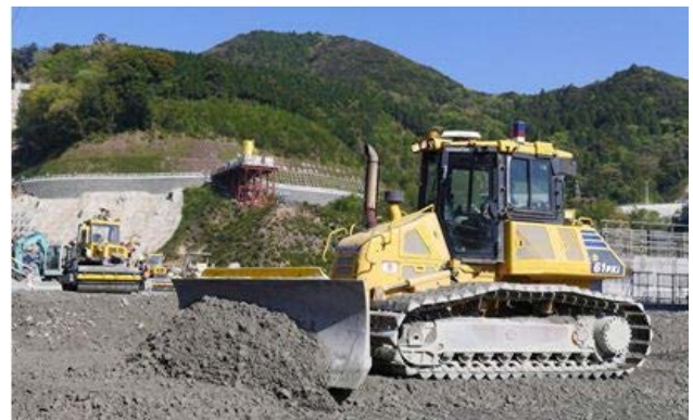
五ヶ山ダムでの稼働状況②
