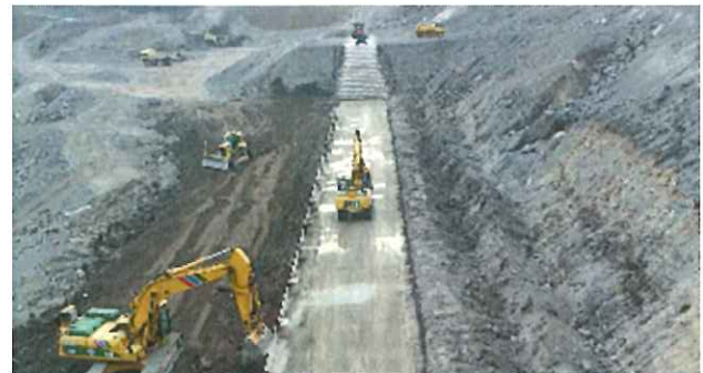
施工盛土および打設前清掃状況
