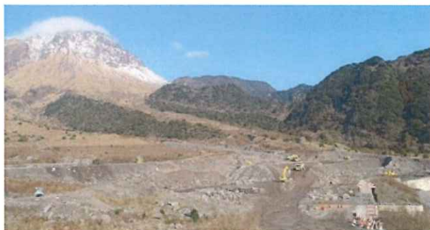
床固工工事全景
